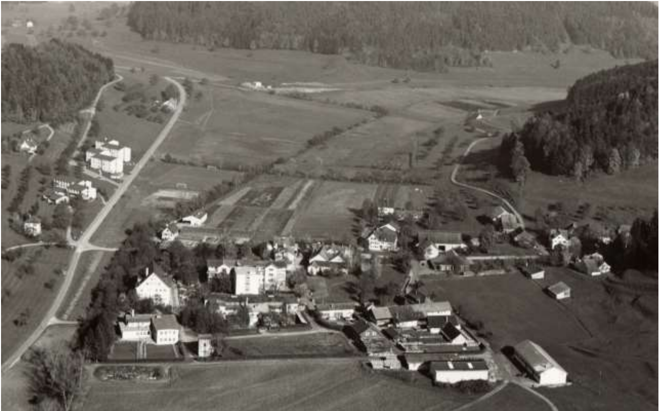
Luftaufnahme von Littenheid um 1970. Ab 1950-1983 führt Hans Schwyn-Müller die Klinik als Einzelfirma. Danach wird sie eine Familien AG. Im Hintergrund erkennbar die neu erstellte Gasstation
